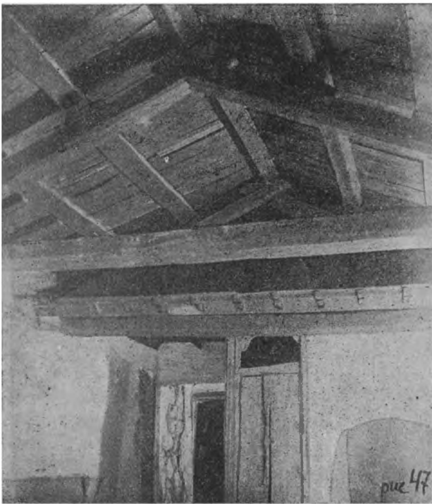
Бахчисарай. Конструкция крыши-потолка в старинном доме. Baktchi-Saraï, Construction du toit-plafond dans une maison ancienne.
